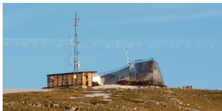
4.6.2010: Teilweise bereits abgebrochene Hütte mit Welterbespirale.
