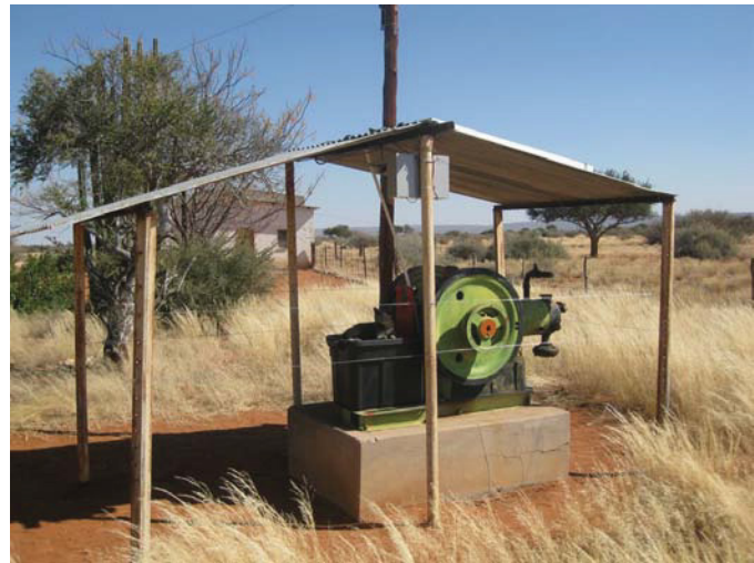
Der alte Dieselgenerator
