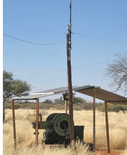
Unterstand mit Bake, Solarpaneelen und Antenne.
