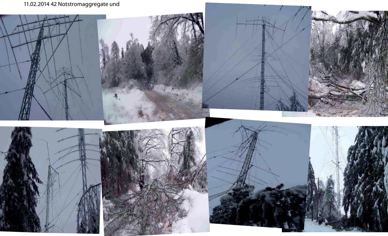
Die zerstörten Antennen der DX-Station S57DX! Dem bis zu 10cm dicken Eis konnten die Antennen und Masten nicht standhalten! Die Bilder sind von niedriger Qualität, da sie während des Einsatzes via Pactor/Winlink übertragen wurden und die Dateigröße Systembedingt limitiert ist. Danke auch an Tilen Cestnik, S56CT für seine tolle Unterstützung während des Einsatzes. Fotos: Slavko, S57DX
