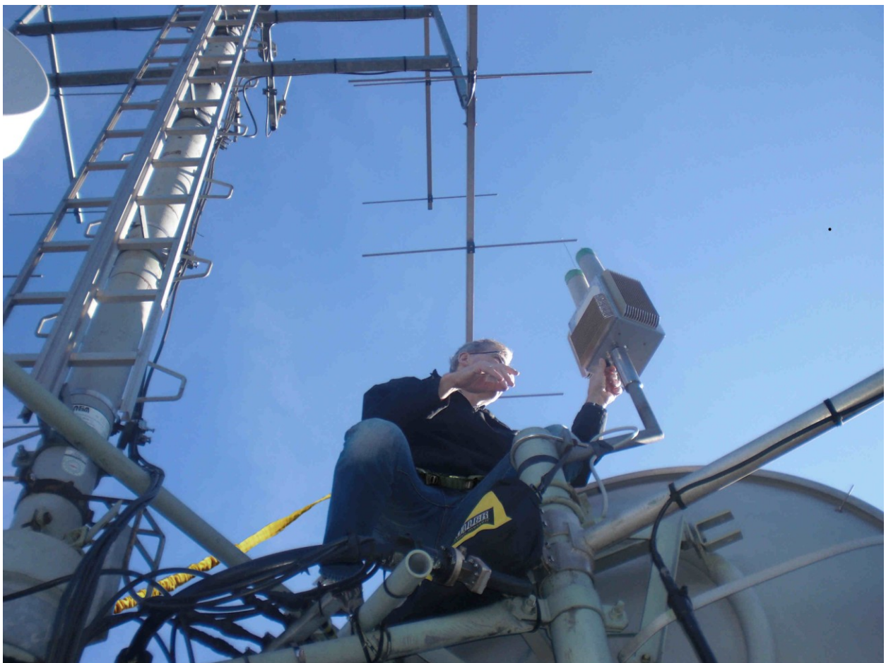
OE5VRL bei der Montage am Turm
