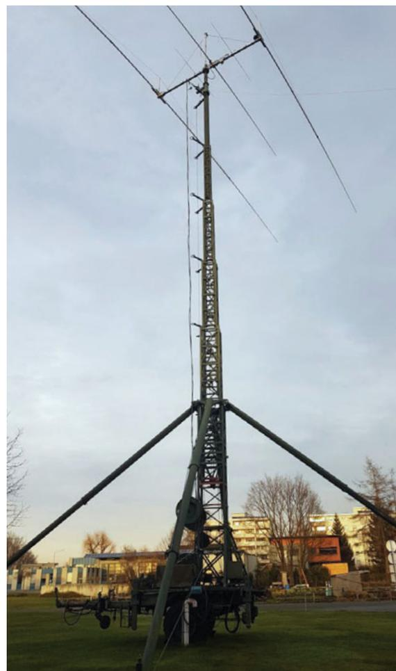
25 m Antennenmast mit Ultrabeam Antenne
