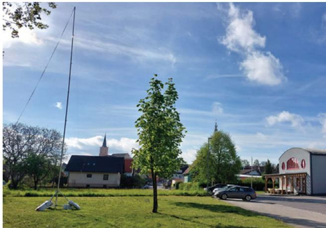
Die Wetterbedingungen waren aufgrund des starken Windes für den Aufbau und Betrieb des mobilen Masten sehr herausfordernd. Mehrmals am Tag wurden Mitglieder der Feuerwehr zu umgestürzten Bäumen in der unmittelbaren Gegend alarmiert. Der Antennenmast trotzte dank umfangreicher Abspannungen dem Wetter.
